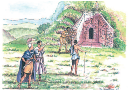
L'ingénieur Nonius Datus indiquant au gouverneur sa stratégie de percement du tunnel de Lahbel.
