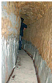
Le tunnel de Lahbel. Photographies inédites réalisées par l'expédition d'Avril 2006. Croquis K. Bourihane
